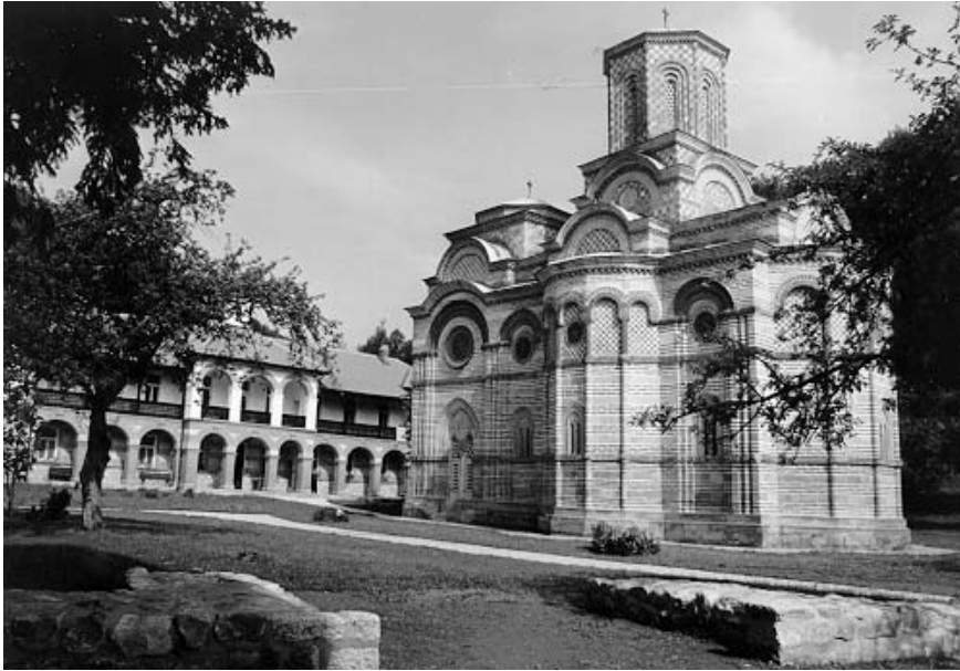
Порћа манастира Каленић је уређена као репрезентативни простор - са пешачким стазама, украсним зеленилом и презентацијом средњовековних зидова и капије
